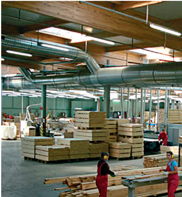
Εικόνα 5. Δίκτυο αεραγωγών και κυλιόμενα απορροφητικά για την απαγωγή της σκόνης ξύλου.
